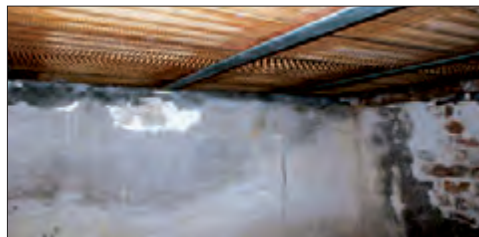
Solaio in putrelle e tavelloni
