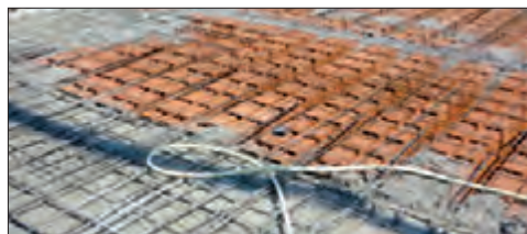
Solaio in laterocemento gettato in opera
